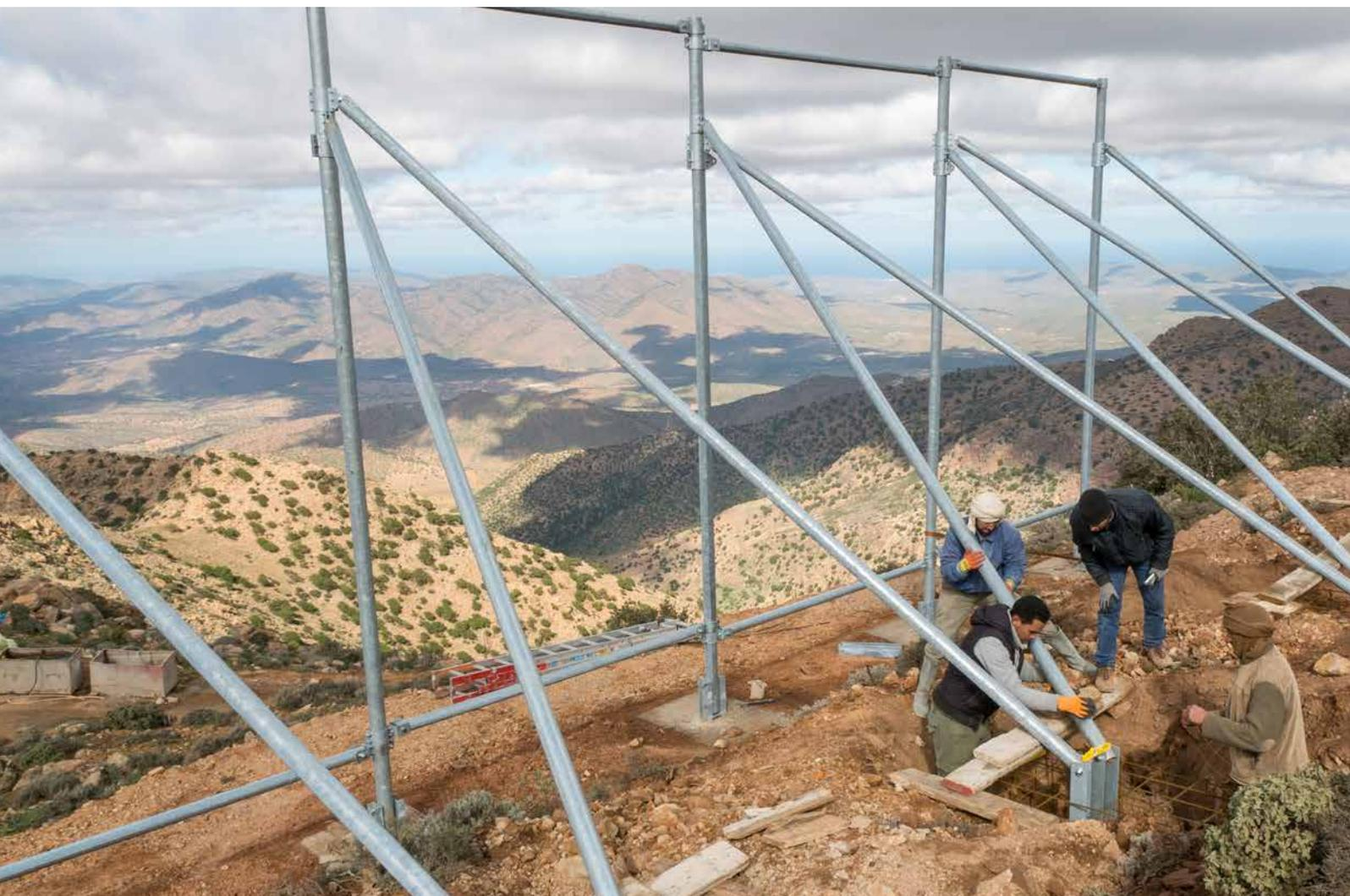
La technologie est rapide et facile à mettre en place et nécessite peu d'entretien. La facilité d'assemblage et d'entretien revêt une importance toute particulière dans les régions dépourvues de ressources, où les moyens financiers et les pièces détachées sont tout au plus limités.
