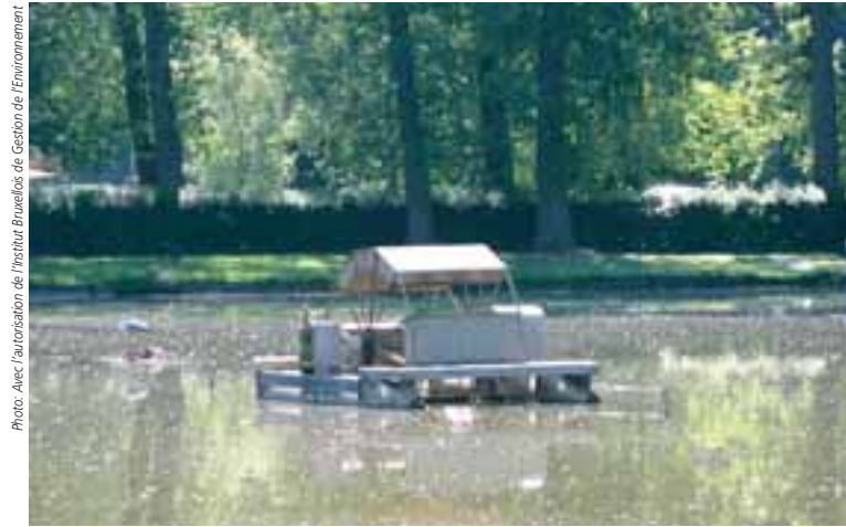
Photo: Avec l'autorisation de l'Institut Bruxellois de Gestion de l'Environnement L'aérateur Chiapattana à l'œuvre sur l'un des étangs Mellaerts, dans le parc de Woluwé-Saint-Pierre à Bruxelles
