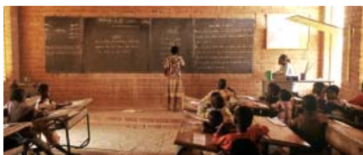
Les méthodes naturelles de ventilation et les murs en terre comprimée permettent de maintenir les salles de classe fraîches en plein soleil.
