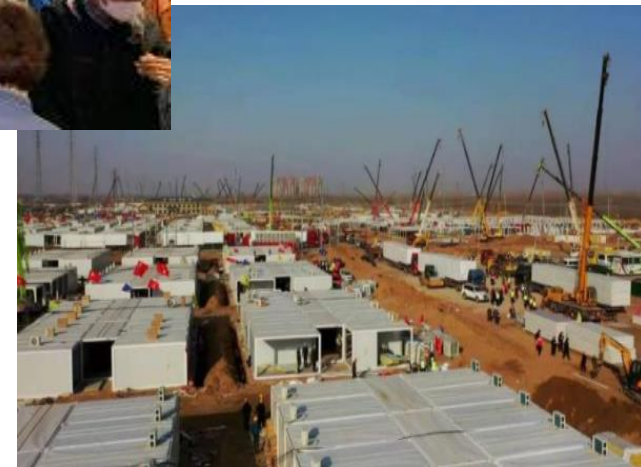
急ピッチで集中隔離用施設を建設 (2021年1月) (出所) 澎湃新聞
