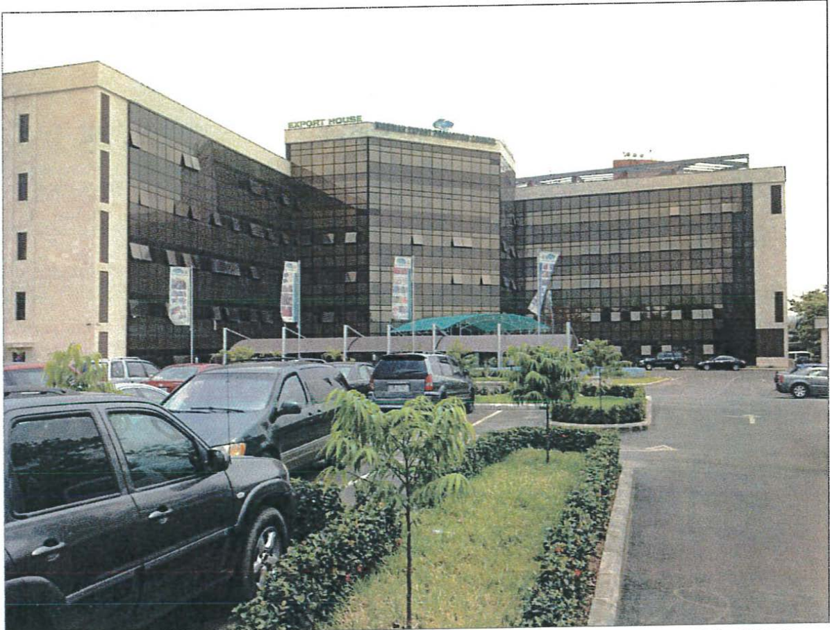
Foto: El edificio Export House del Consejo de Promoción de las Exportaciones de Nigeria (NEPC). Edificio propuesto para albergar la oficina externa de la OMPI en Nigeria
