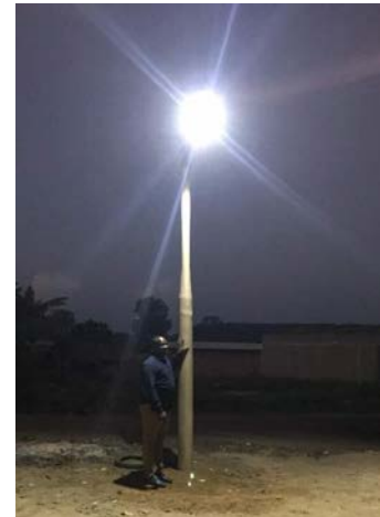
村に設置した街路灯
